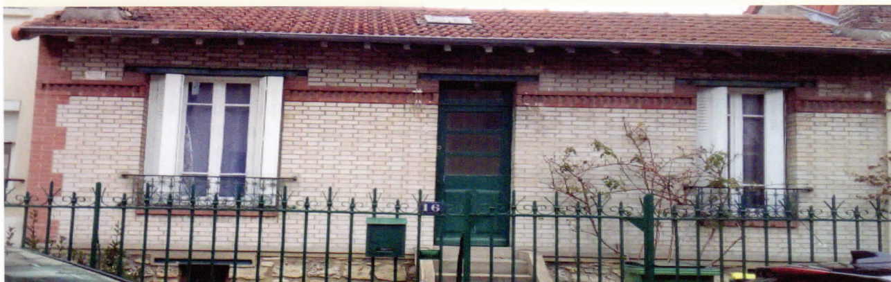
Maison rue de Liège. Photo H. Duval, 2023
